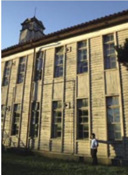
▲旧本館と佐々木さん。撮影時に確認すると、なぜかラーメン屋はありませんでした。
