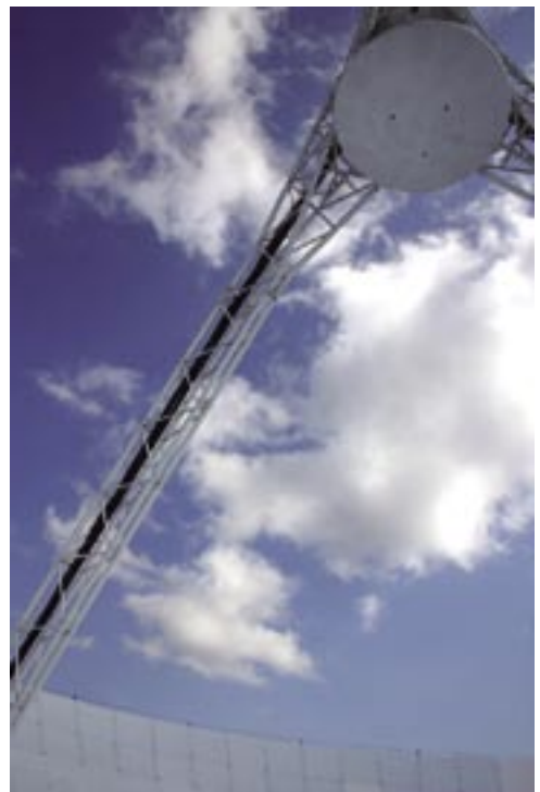
◀▲45m鏡の主鏡面の小窓から顔を出すと、大アンテナはこんな感じに見えました。左は主鏡面パネル、上は下から見上げた副鏡。
