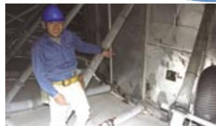
▲45m 鏡内の骨組み。上面は主鏡面パネル、下面は日除けパネルに覆われて暗い。御子柴さんが指差すのは、久野さんらと試験中の主鏡変形測定用小型望遠鏡。保守のみならず、技術開発によって45m 鏡は日々進化する。
