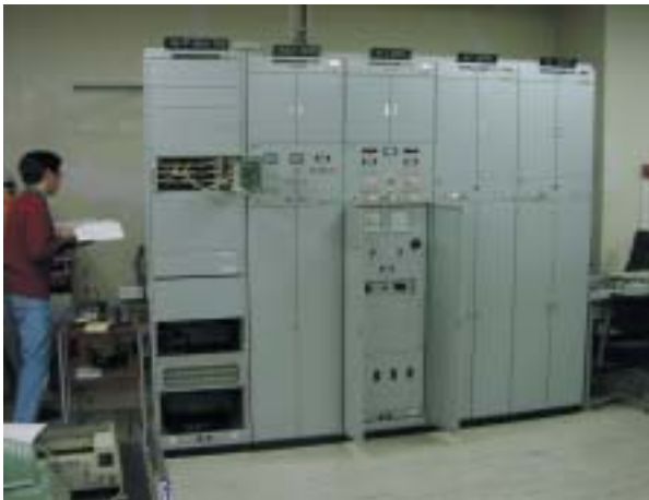
図4. 既存のアンテナ制御部 プログラム追尾装置（この写真には写っていない）は、この既存のアンテナ制御部を通してアンテナを制御・天体を追尾する。左はKDDIの酒井さん。
