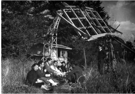
図01 1949年、三鷹で200MHz強度観測開始。約5m x 2.5mの木枠にダイポール・アンテナを8組ならべたものであった。赤道儀は可視光望遠鏡に使用されたものを流用したらしい。
