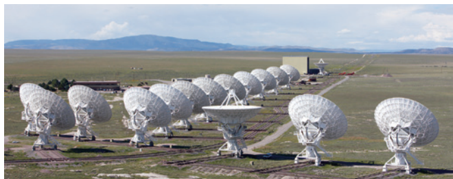
図13 アメリカのVLA(カール・ジャンスキー超大型干渉電波望遠鏡群)は、25mアンテナ27基がY字型に設置され、観測を行っている。★
