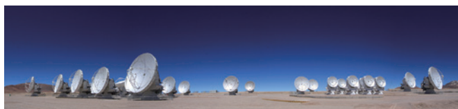
図14 日本も参加するチリのアルマ望遠鏡は、12mと7mアンテナの合計66基でミリ波・サブミリ波を観測する世界最高性能の電波干渉計。
