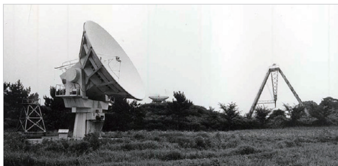
図07 1970年、三鷹に設置された6mミリ波宇宙電波望遠鏡。右奥は24mの固定式球面電波望遠鏡(裏表紙も参照)。
