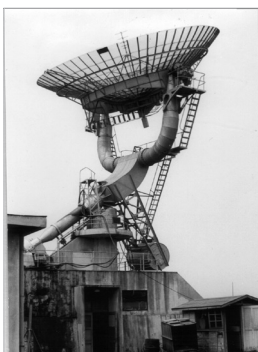
図03 1953年、三鷹で10mパラボラアンテナによる3GHzでの観測開始（表紙も参照）。
